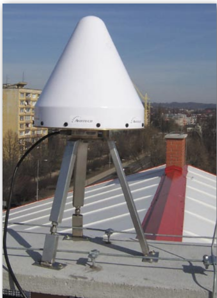
3. Montaż anteny GPS przy użyciu uniwersalnego statywu
